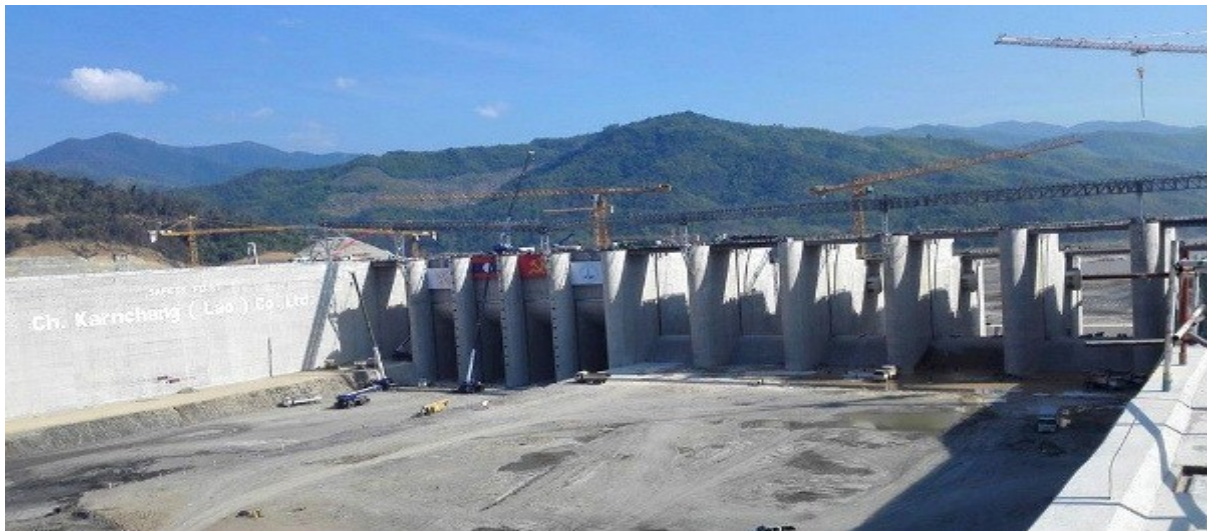
Baustelle des Xayaburi-Staudamms, aufgenommen im Jänner 2015. Mit der Umleitung des Mekong durch einen Hilfsdamm wurde Ende Jänner die zweite Bauphase des Projekts eingeleitet. (Foto: International Rivers)
