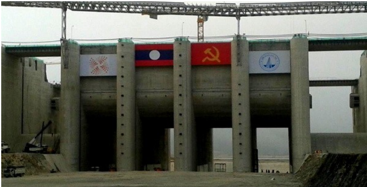
Baustelle des Xayaburi-Staudamms, Jänner 2015. (Foto: International Rivers)
